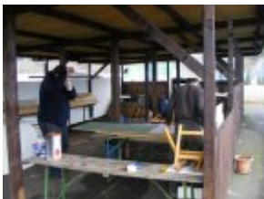
Vorarbeiten im Fahrerlager
