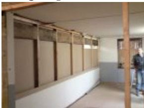
Neue Wand eingezogen
