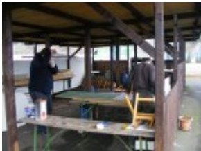
Vorarbeiten im Fahrerlager
