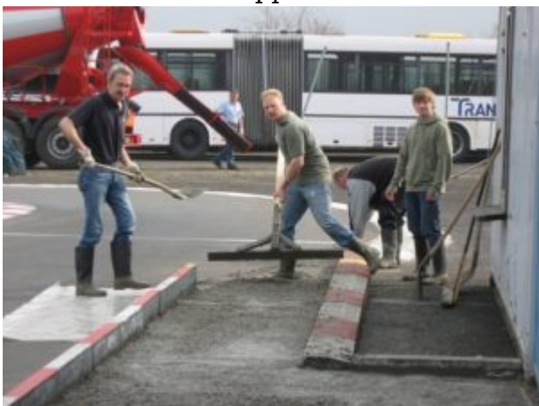
Der Beton ist endlich drin
