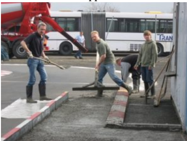
Der Beton ist endlich drin
