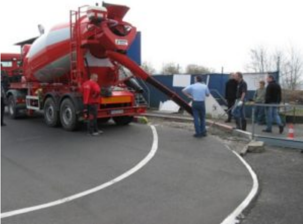
Betonmischer auf der Gerade
