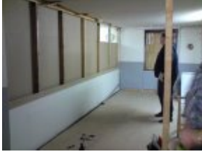
Auf der Baustelle in der Küche vom MCC
