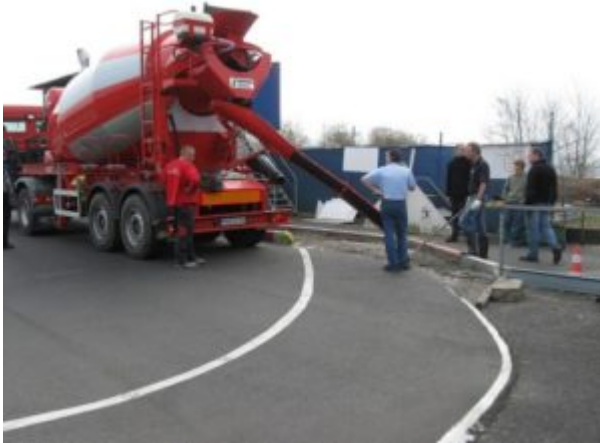
Betonmischer auf der Gerade
