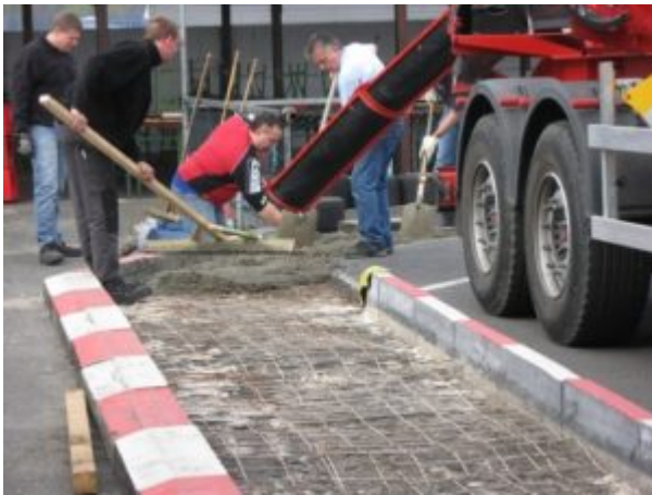
Beton wird verteilt
