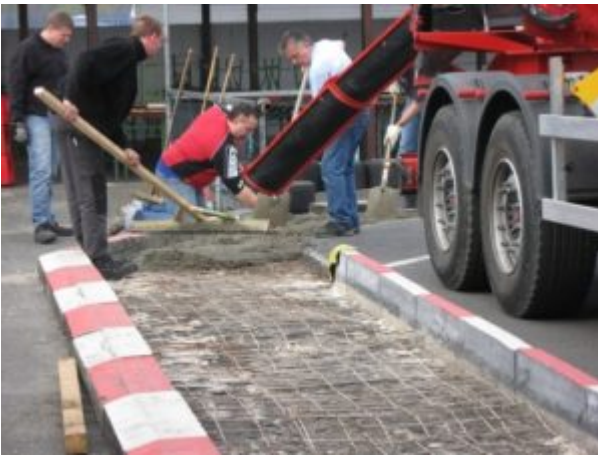
Beton wird verteilt
