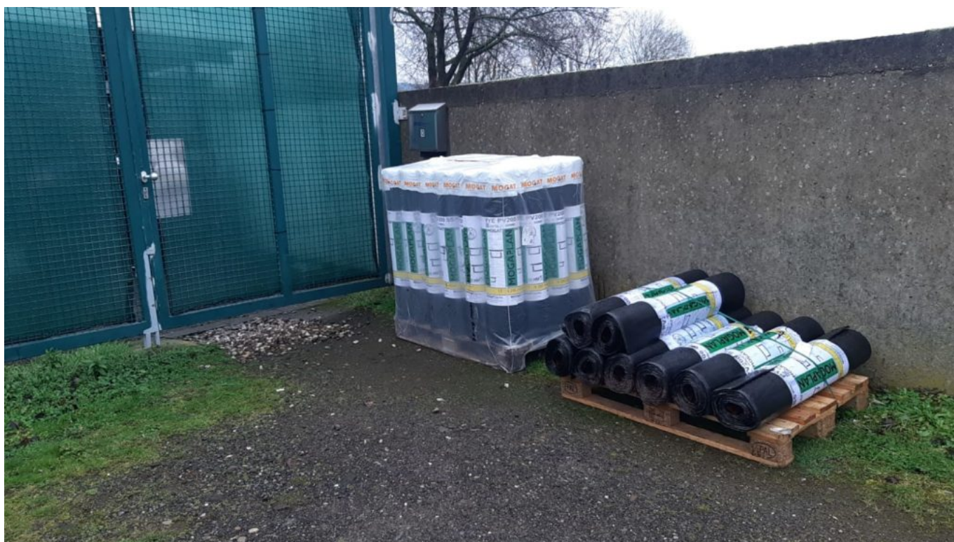
Neues Material für das Dach
