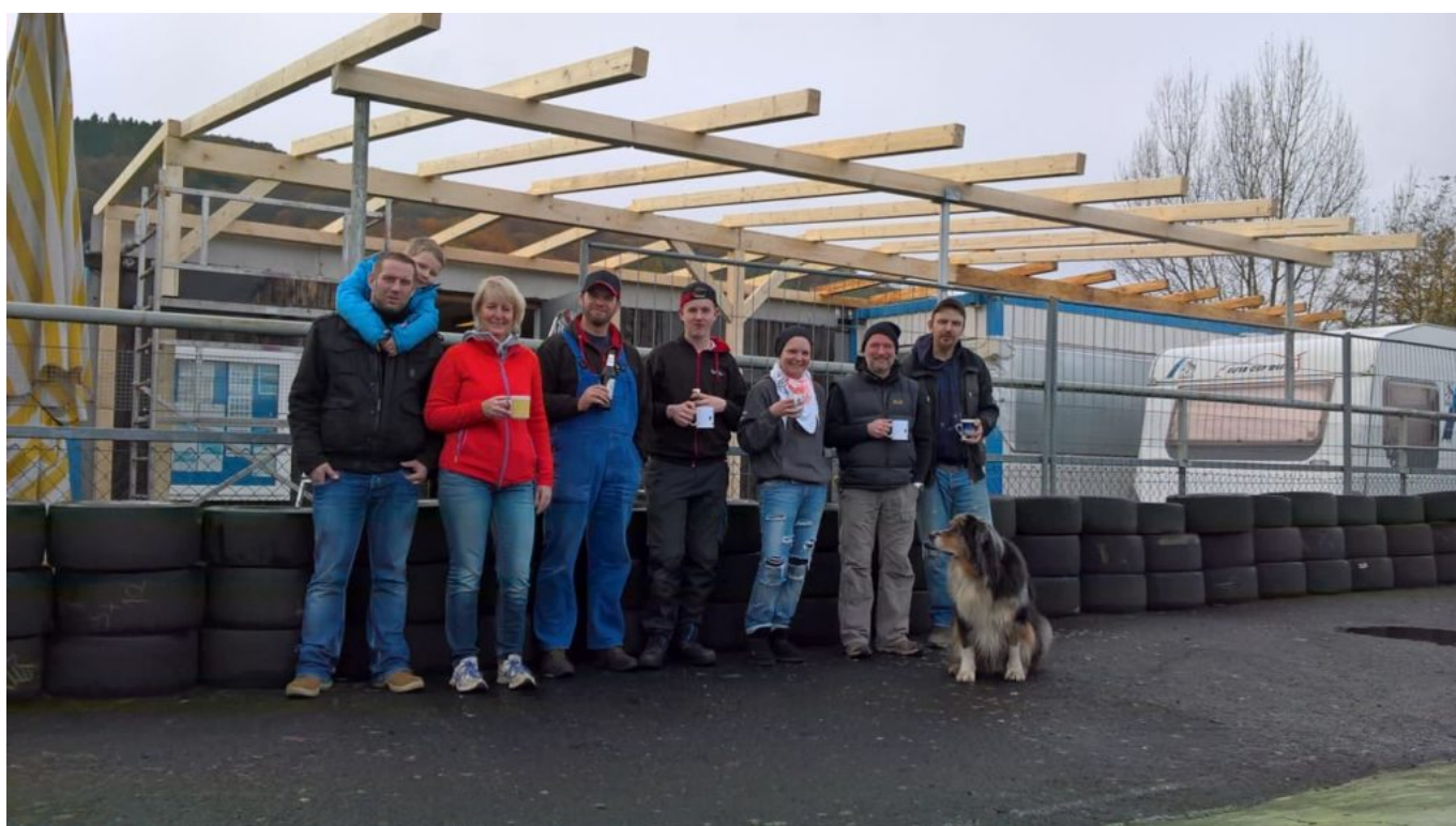
Neues Dach vor dem Vereinsheim
